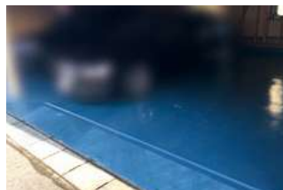
防水塗装施工
