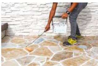
スピード施工
