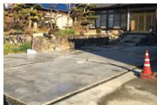
土間コンクリート
